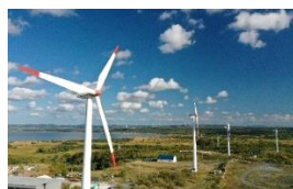
稚内風力発電所
