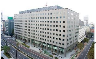
道庁南エネルギーセンター
