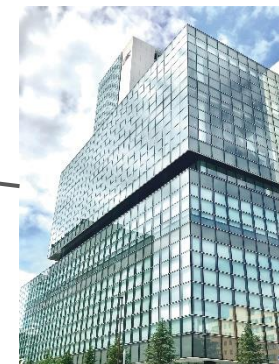
創世エネルギーセンター
