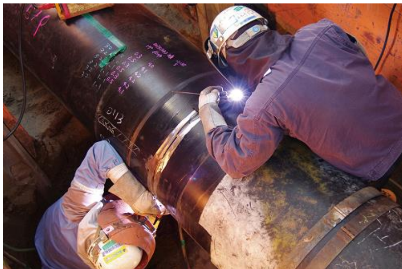
中圧・高圧管 耐震性の高い溶接鋼管
