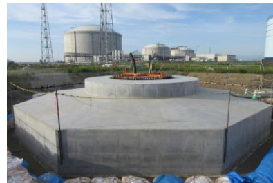
▲北ガス石狩風力発電所建設工事の様子
