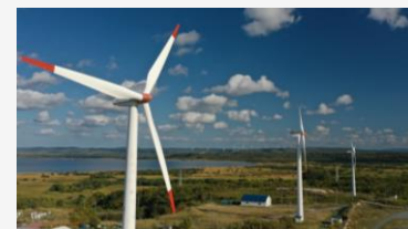
稚内風力発電所
