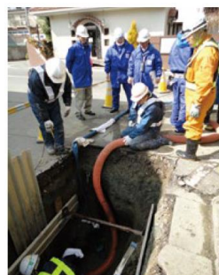
ガス導管の修繕作業 (仙台市)
