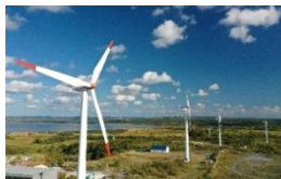
稚内風力発電所
