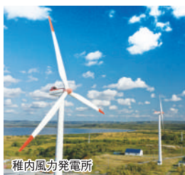
稚内風力発電所
