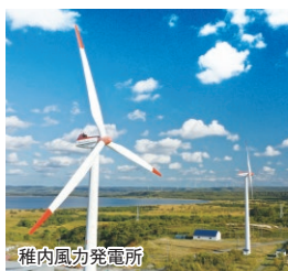
稚内風力発電所
