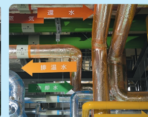
街区内へエネルギーを送る温冷水導管など
