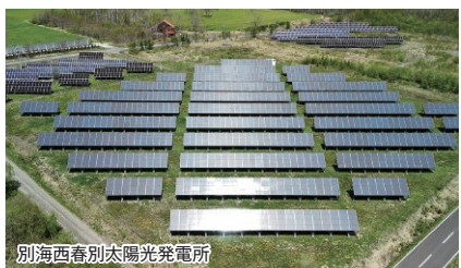
別海西春別太陽光発電所
