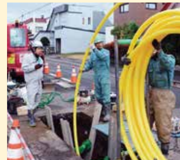
ポリエチレン管への入替工事
