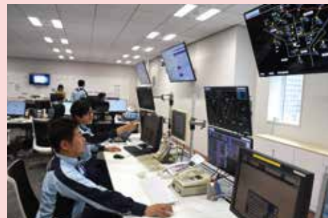
供給防災センター
