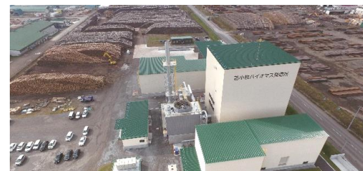
苫小牧バイオマス発電所
