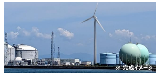
北ガス石狩風力発電所 (2024年度完成予定)
