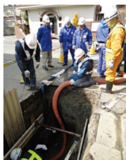
ガス導管の修繕作業 (仙台市)
