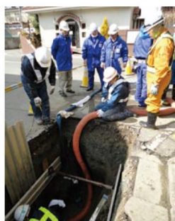
ガス導管の修繕作業 (仙台市)
