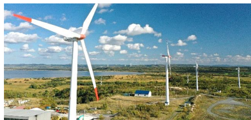
稚内風力発電所
