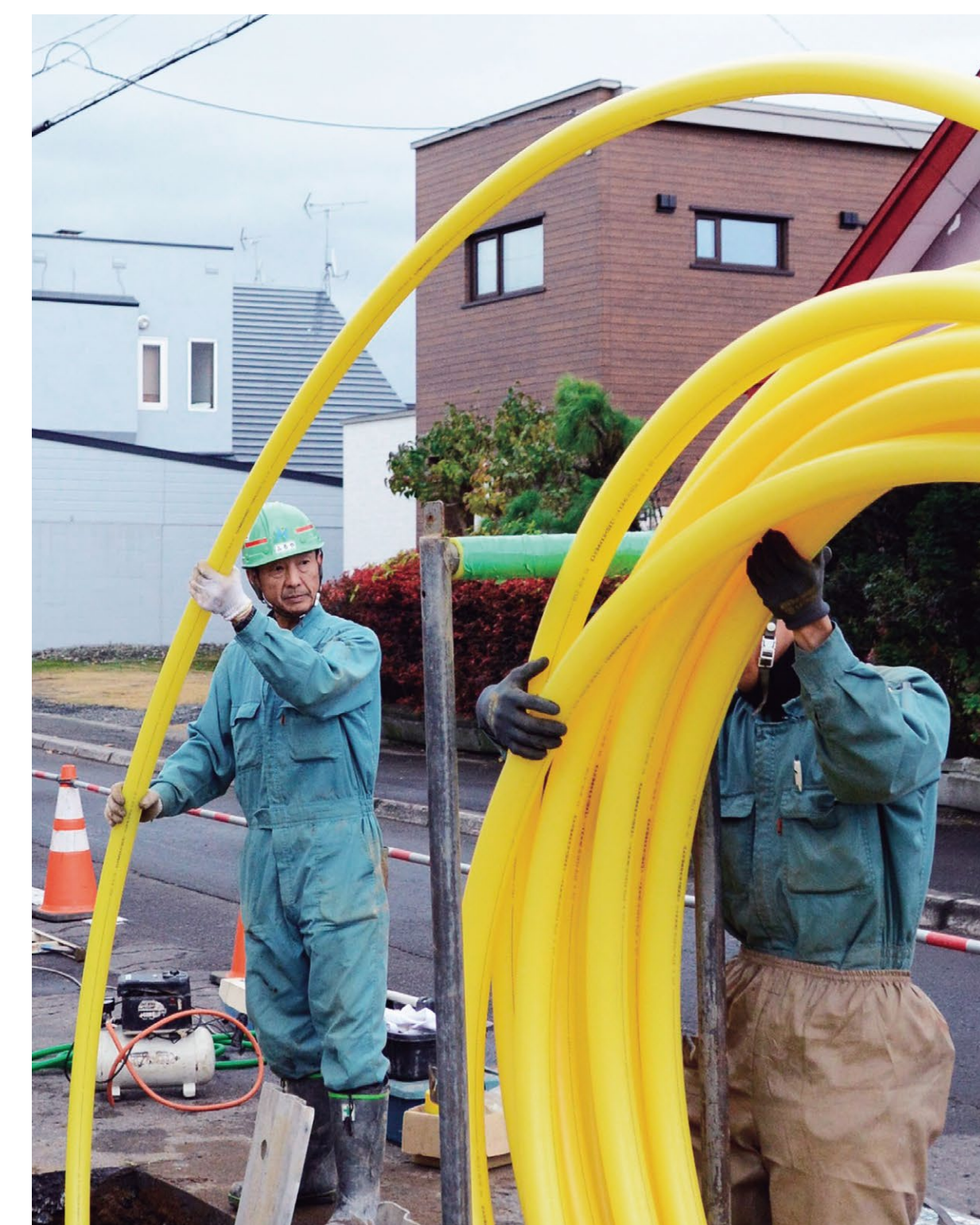
ガス導管に使用している黄色いPE管
