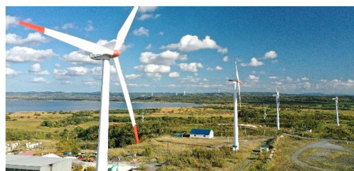
稚内風力発電所
