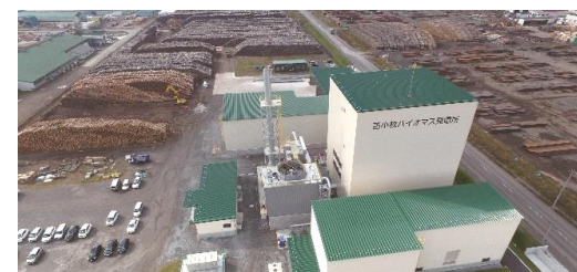
苫小牧バイオマス発電所
