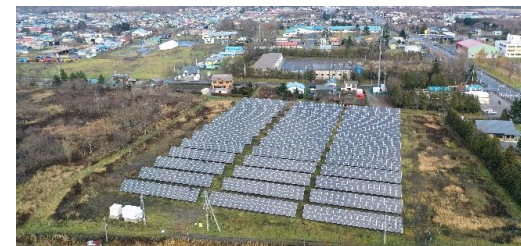
芦別太陽光発電所
