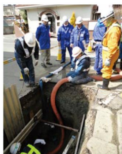
ガス導管の修繕作業 (仙台市)
