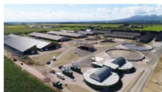
バイオガスプラント
