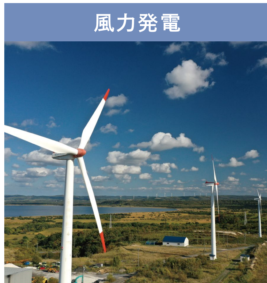
稚内風力発電所
