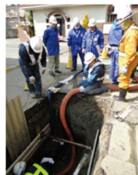
ガス導管の修繕作業 (仙台市)
