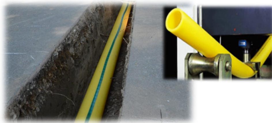
ポリエチレン管 「腐食に強く、耐震性に優れる」
