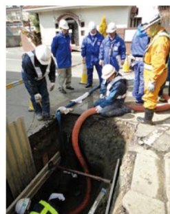
ガス導管の修繕作業 (仙台市)
