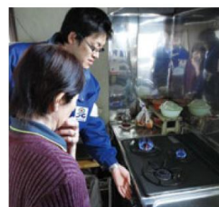
全戸で安全点検し ガスの開通を確認 (仙台市)
