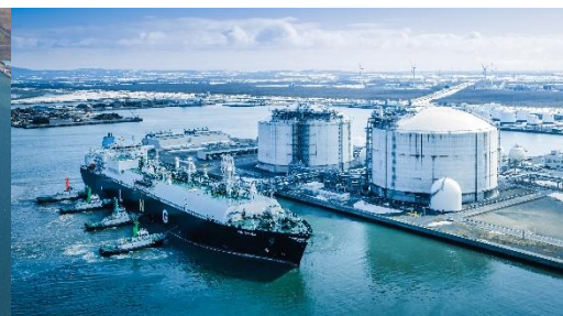
(Reference: The Company’s Ishikari LNG Terminal)
