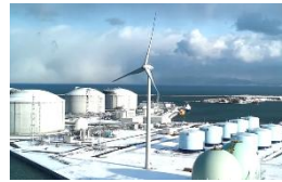
北ガス石狩風力発電所
