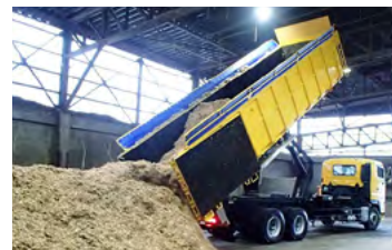
バイオマス貯留庫
