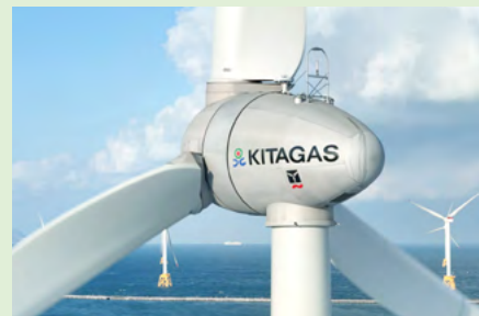
石狩風力発電所は、北ガスグループとして初となる自社建設の風力発電所として2025年に運用を開始しています
