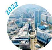
新さっぽろエネルギー センター運転開始
