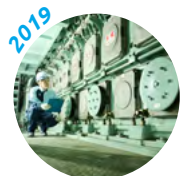
北ガス札幌発電所 運転開始
