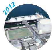
石狩LNG基地 操業開始
